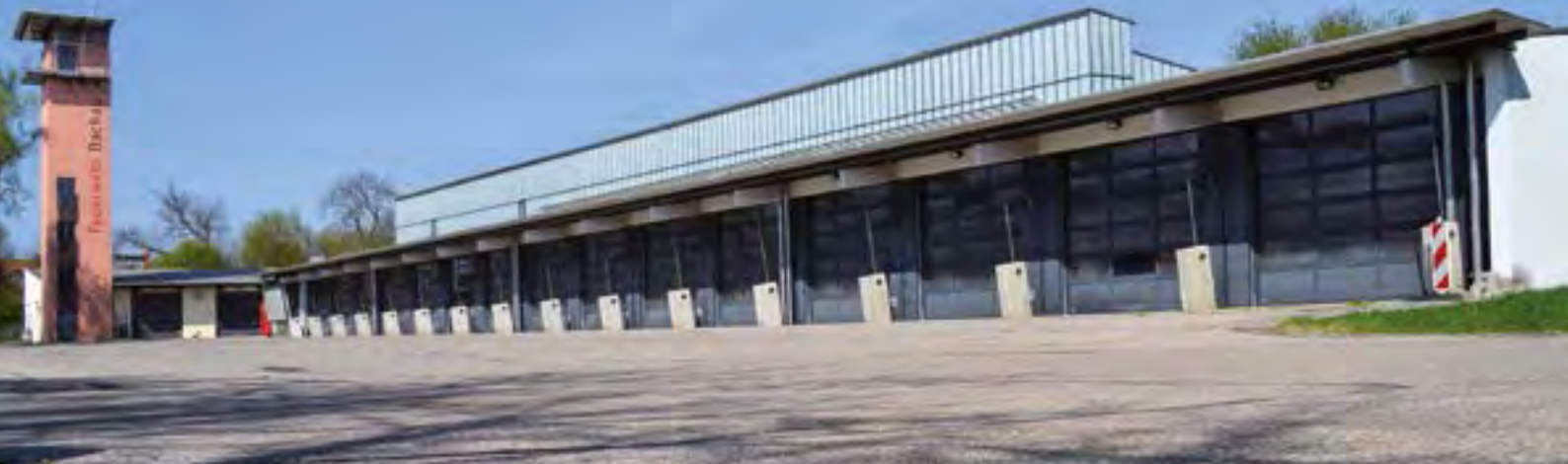
Das Gerätehaus am Fritz-Müller-Weg
